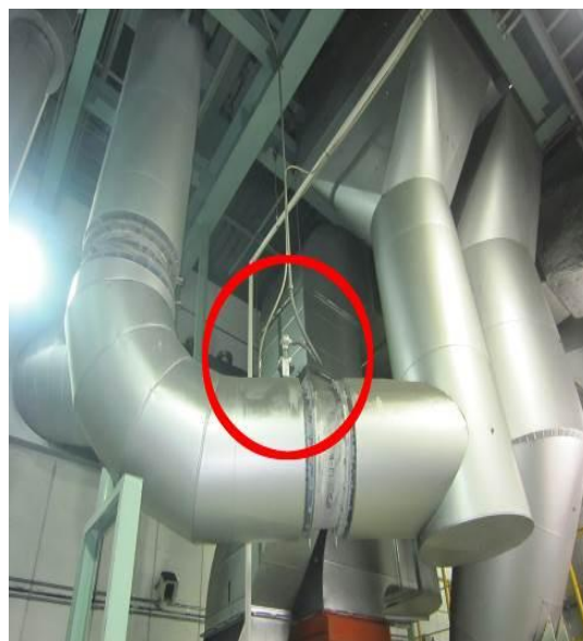
【位置図2】集じん機ダクト
