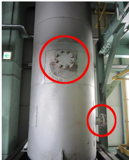
※測定位置図【排気筒3階部】
