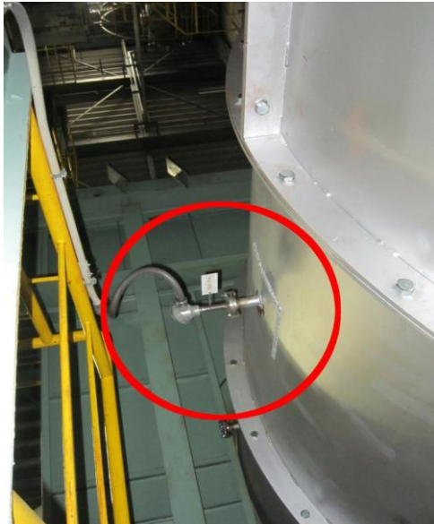
【位置図1】脱臭炉4階部
