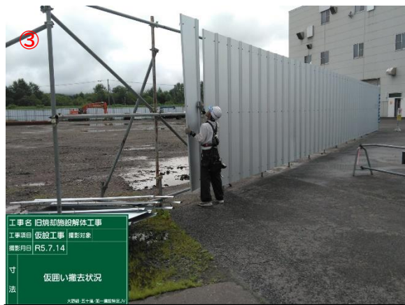
仮囲い撤去状況
