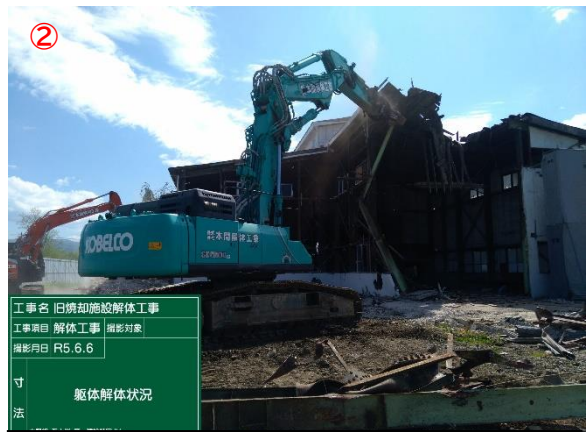
躯体解体状況
