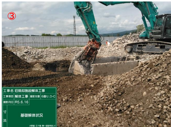
基礎解体状況
