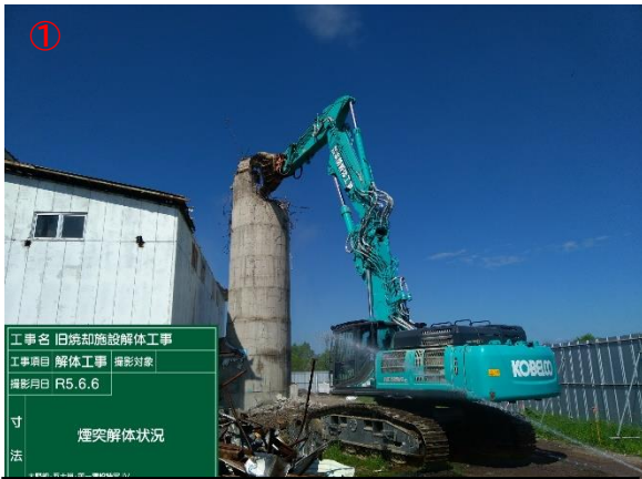
煙突解体状況
