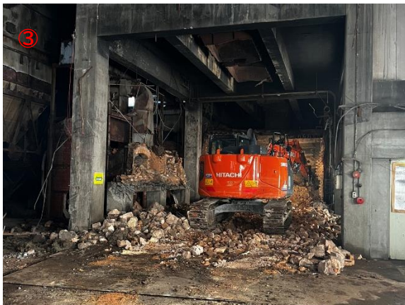
焼却炉 機械解体状況①
