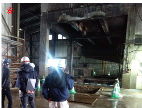
解体撤去後現場確認
