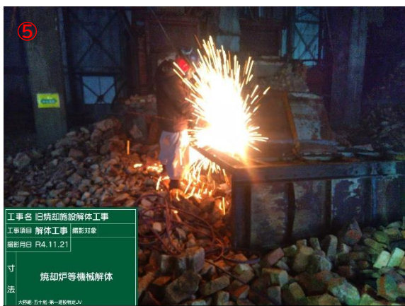
設備等ガス溶断作業
