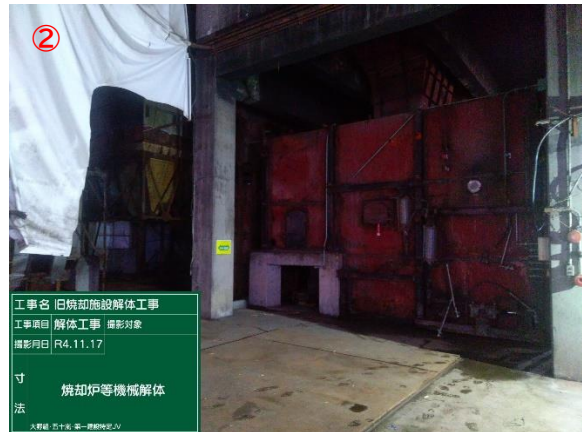
焼却炉 解体前
