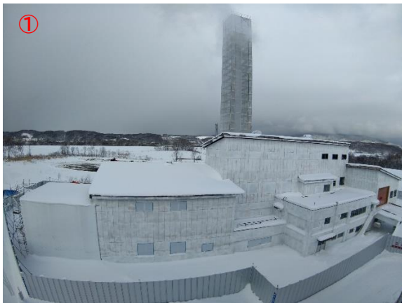
建屋南面 外観
