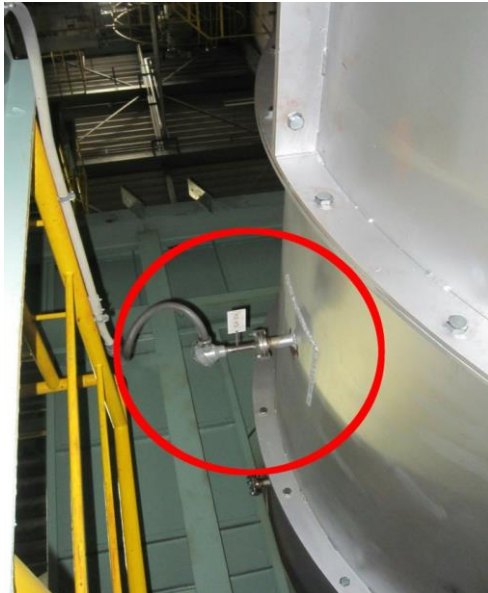
【位置図1】脱臭炉4階部
