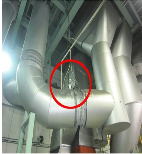
【位置図2】集じん機ダクト
